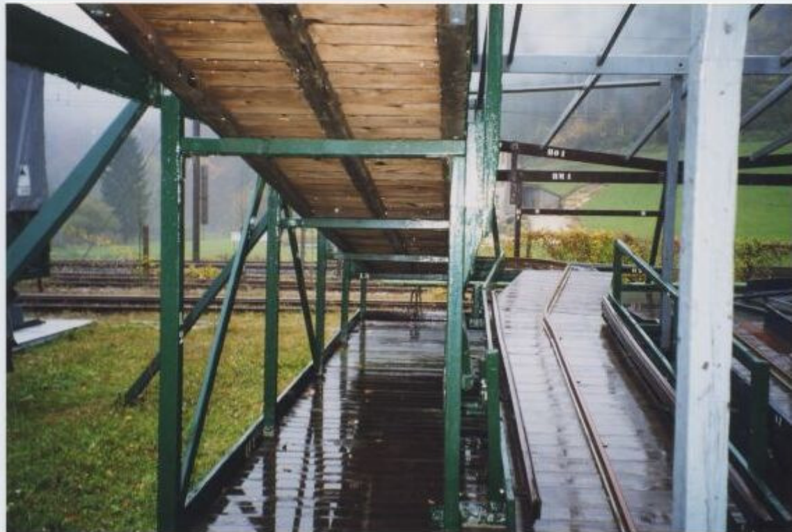
Oben: Erste Abfahrtsrampe von der Kehre unten her betrachtet. Unten: Erste Abfahrtsrampe von unten und zweite Abfahrtsrampe mit „Knick“ in der Schiene.
