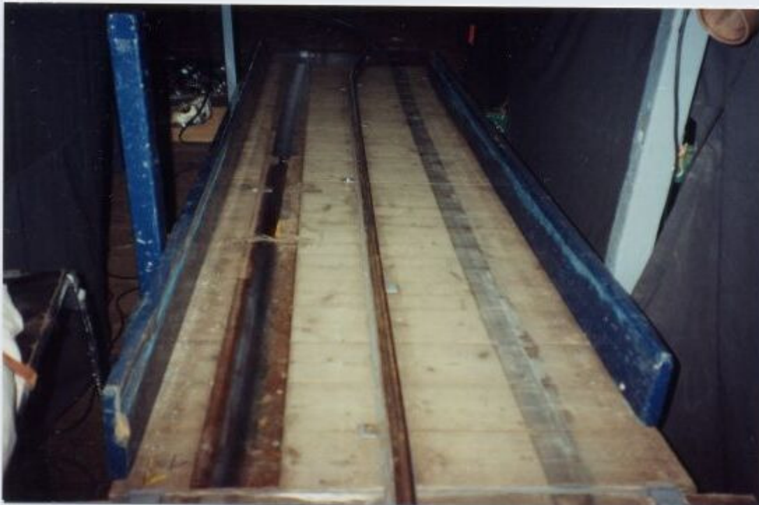
Oben: Kurve bei der zweiten Einfahrt mit Ansatz der ersten Auffahrtsrampe. Unten: Erste Auffahrtsrampe von oben (bei Erscheinung Nr. 9).
