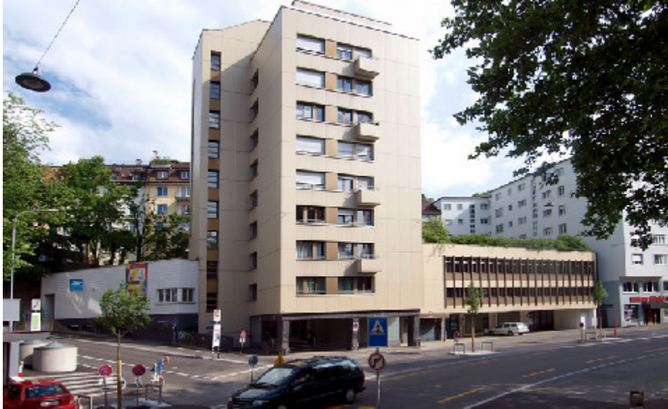
Gamaschenartige, d.h. partielle Fassadenverkleidung, Lämmlisbrunnenstr. 34, 9000 St. Gallen
