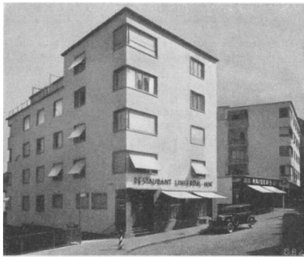
Abb. 4. Front an der Lfsebhühlstrasse.
