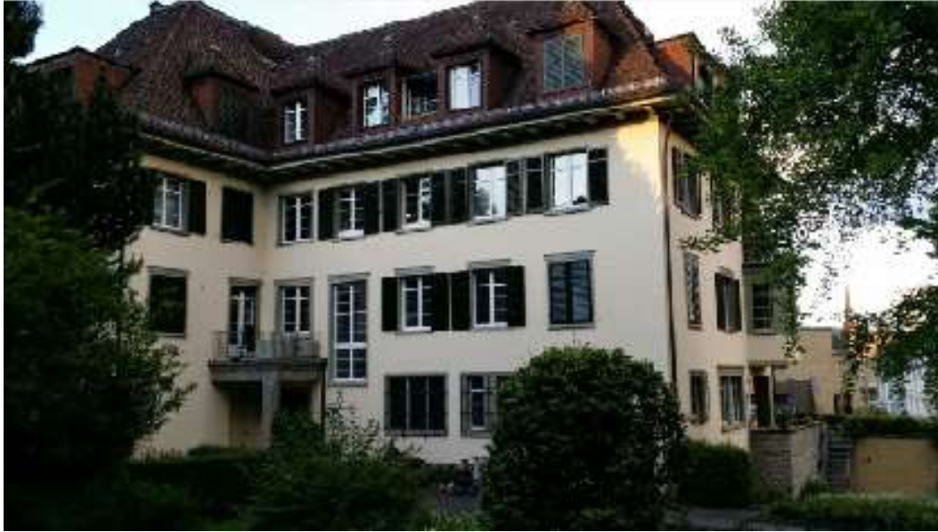
Schulhausstr. 6, 6a, 8002 Zürich
