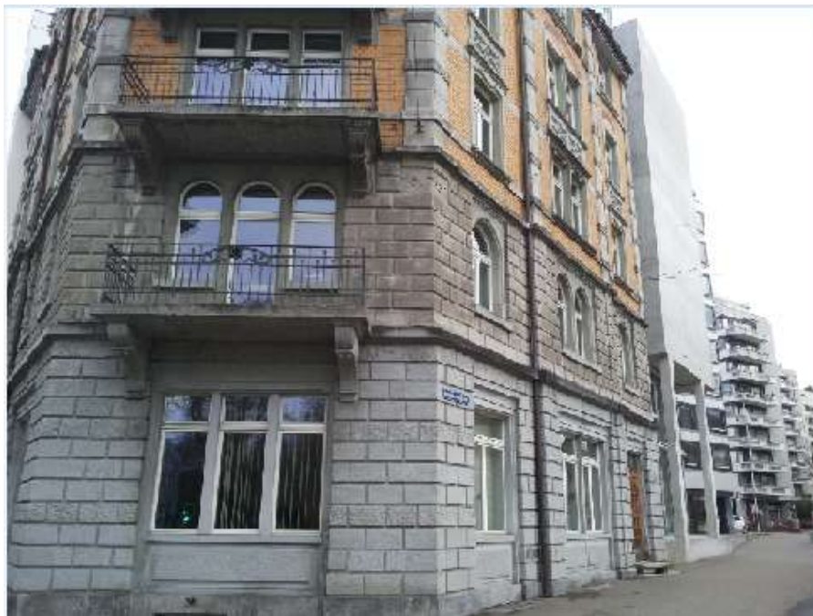
Lämmlisbrunnenstr. 62/Ecke Sternackerstr. mit der linearisierten Häuserzeile an der Lämmlisbrunnenstraße (2014)
