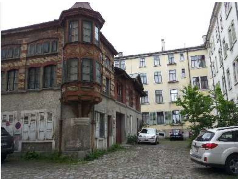
Nicht-numeriertes Haus im Hinterhof der Notkerstr., 9000 St. Gallen
