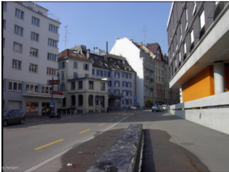
Blick vom Neubau des Ergänzungsbaus der Kantonsschule zum Sántis-Hof und ins obere Lämmli-brunn. Das vorgelagerte zweistöckige Häuschen ist das ehem. Rest. Schlüssel (Lämmli-brunnenstr. 18).
