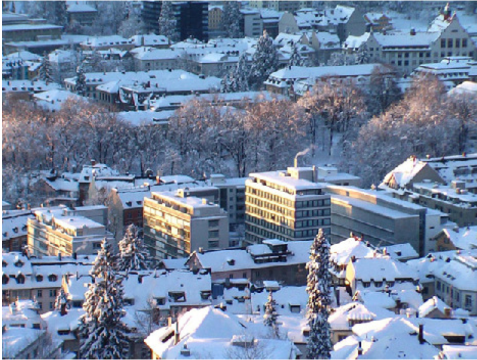
Ansicht von Süden auf die drei Lämmlisbrunn-Hochhäuser Nr. 44, 50 und 54 (v.l.n.r.). Photo: dipl. Arch. ETH Urs Fischer.
