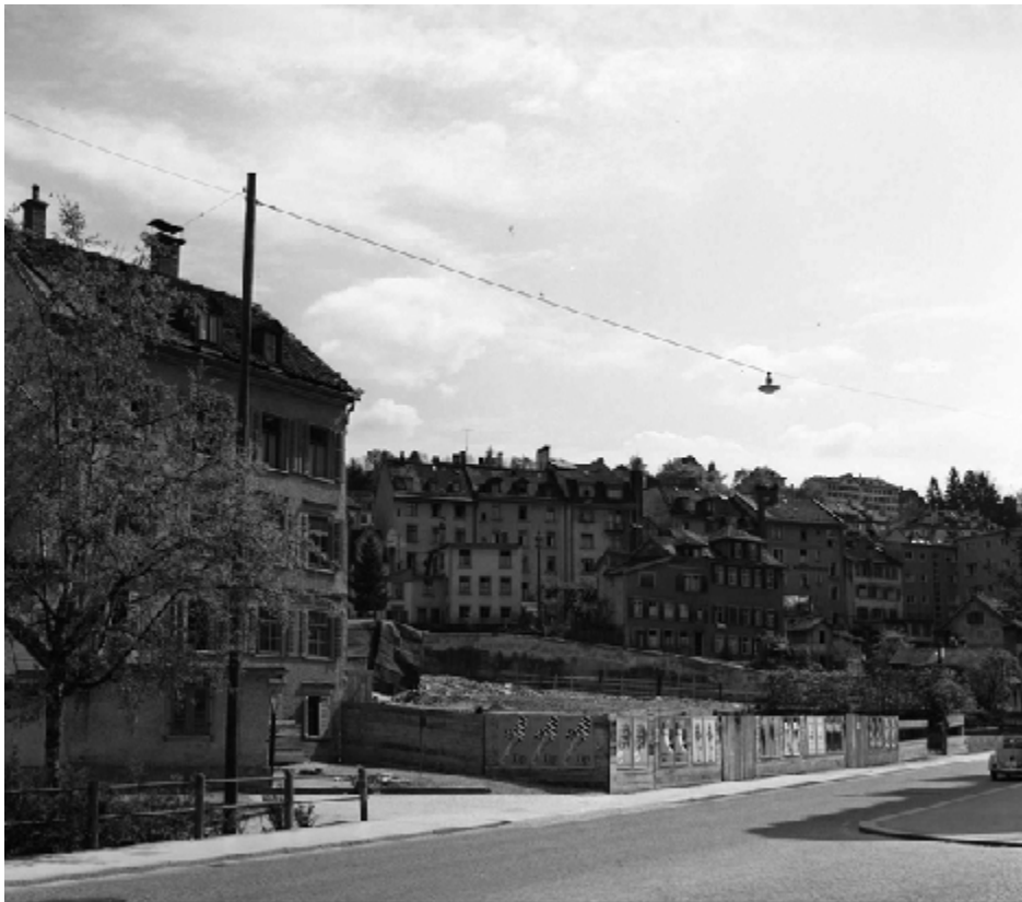
1956. Links Lämmli brunnenstraße 54, mit Großaufnahme im folgenden Bild.
