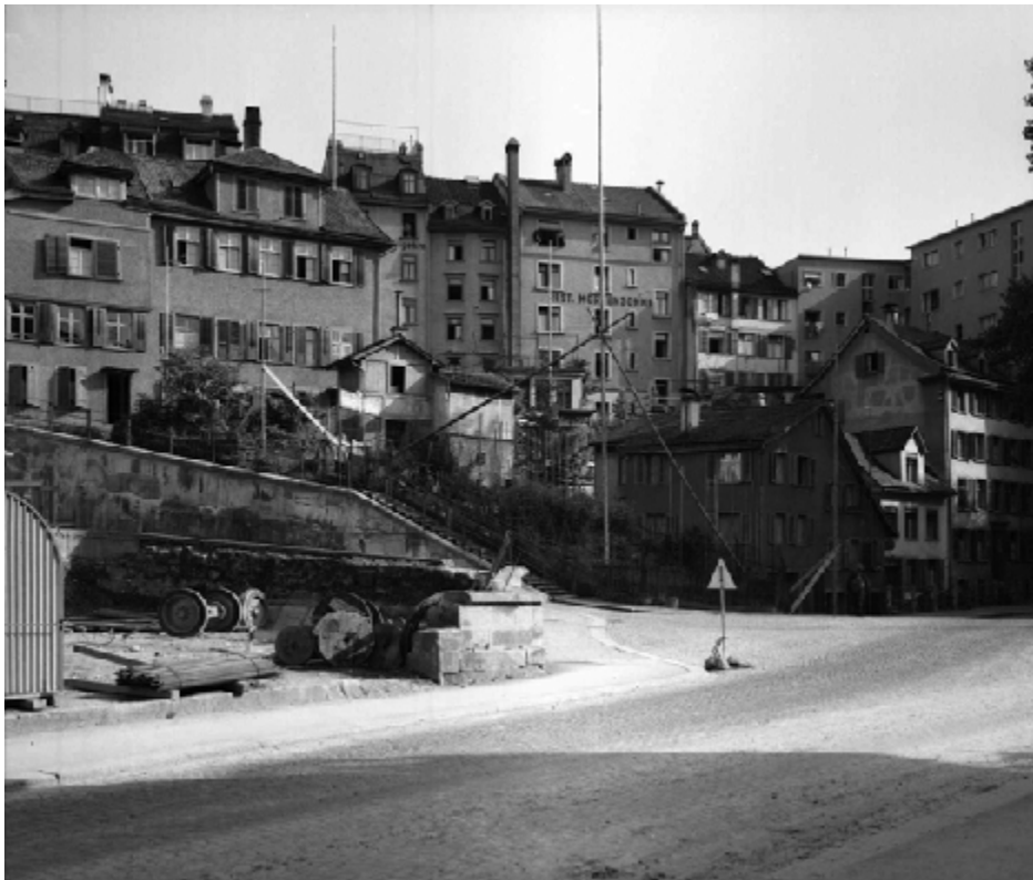
Die Hang-Bauten Lämmlisbrunnstr. 36/36a bestehen 1956 noch.
