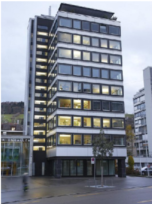
Das Hochbauamts-Hochhaus, Lämmli Brunnenstr. 54, steht an der Stelle der Vorgängerbauten Lämmli Brunnenstr. 56/56a sowie Säggässlein 2 (und teilweise auf dem Grundstück von Säggässlein 1).
