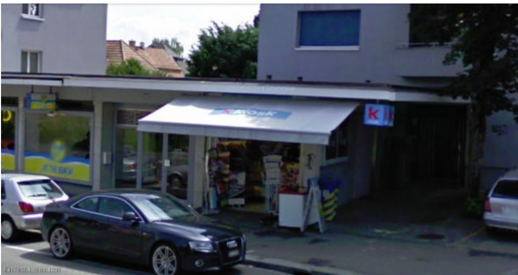
Kiosk, Albisriederstr. 369, 8047 Zürich. Die Offenheit bezieht sich auf die indirekte Verbindung des Kiosks mit dem Haus der gleichen Nummer, via Vordach.
