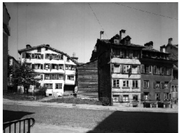
Einmündung des Büschengässchens in die Lämmli-brunnenstraße (1954)
