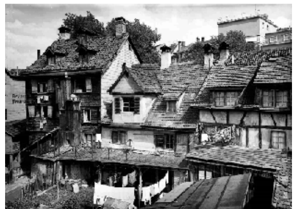
Zwischen Lämmli-brunnenstraße und Büschengässchen (1955).
