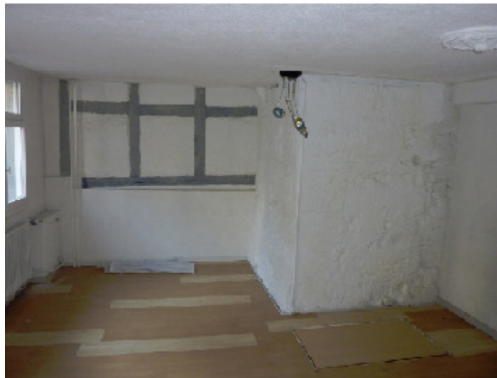
Natursteinwand, Kohlenberg 4, 4051 Basel (1669)
