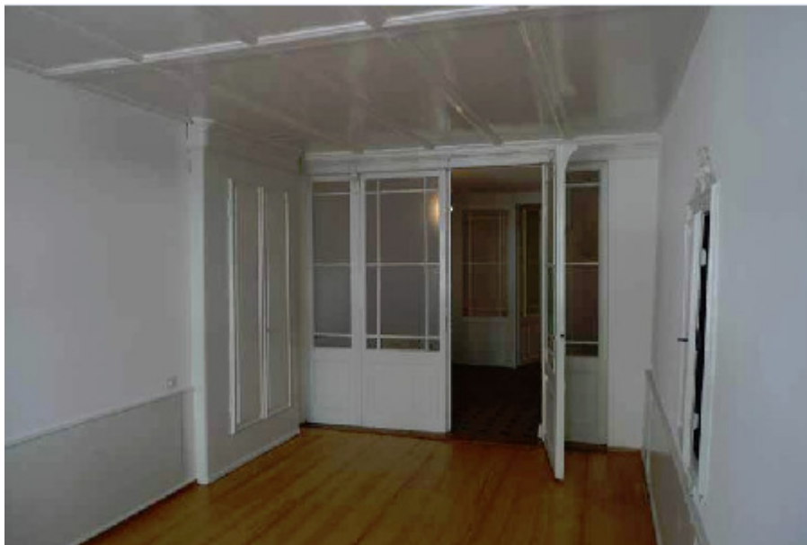
Holzplattendecke, Spalenberg 57, 4051 Basel (1300)
