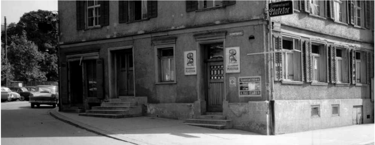
Unterschiedliche Adaptationen der Treppenstufen, ehem. Rest. Platztor, St. Gallen (1961)
