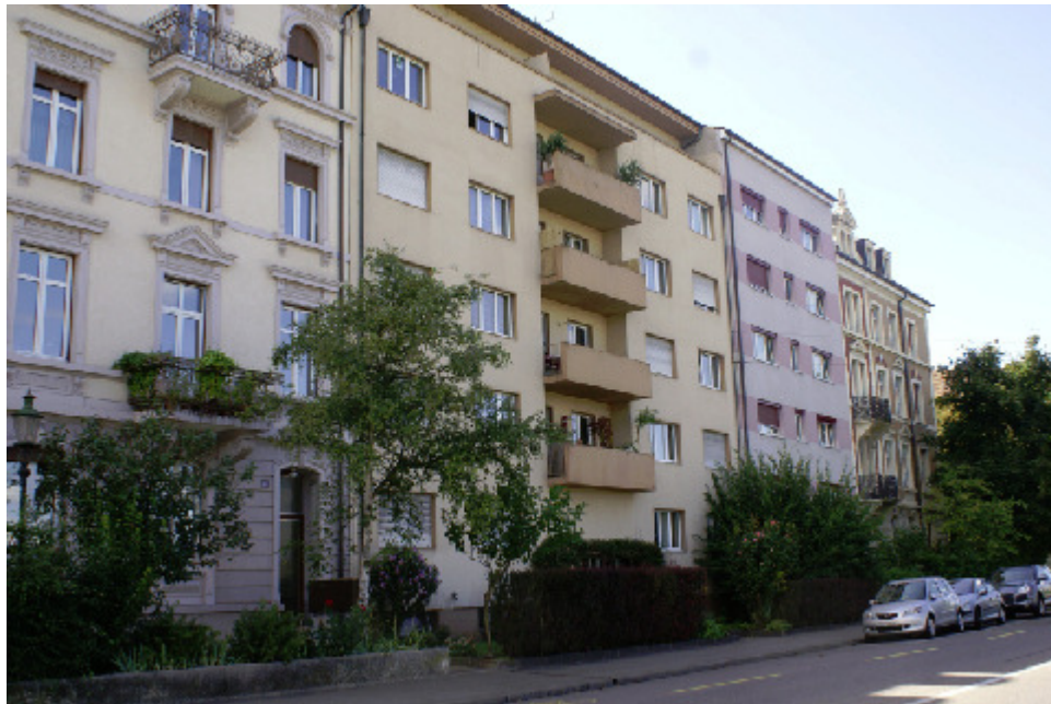
Partiell adaptierte Zwischenhäuser, Münchensteinerstrasse 150 (1968) und 152, 4053 Basel
