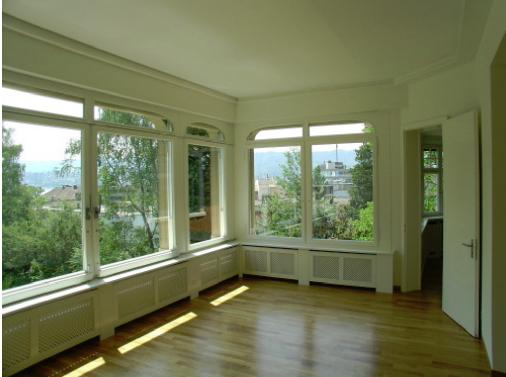
Partiell adaptierte Radiatoren, Arosastr. 7, 8008 Zürich (1903)
